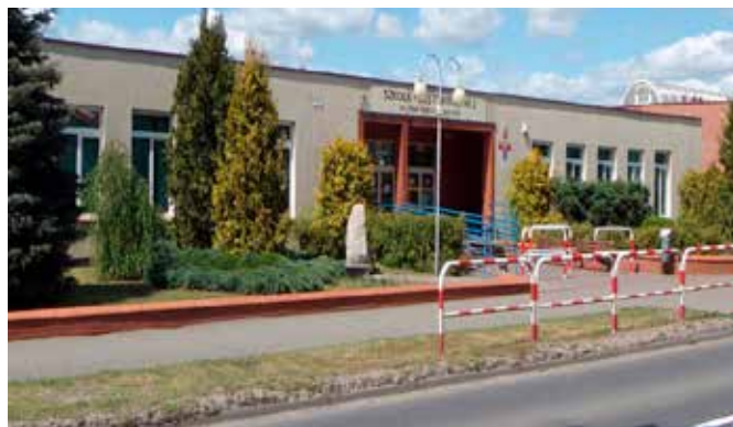
Remont podjazdu i schodów w SP Nr 2 w Wieleń
