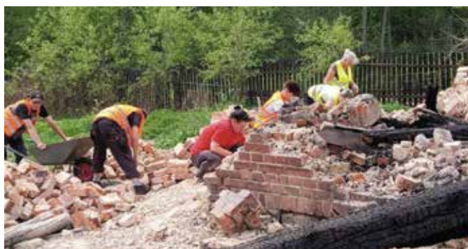
Świadczenie usług na rzecz jednostek organizacyjnych Gminy, warsztat remontowo-budowlany CIS, sierpień 2022
