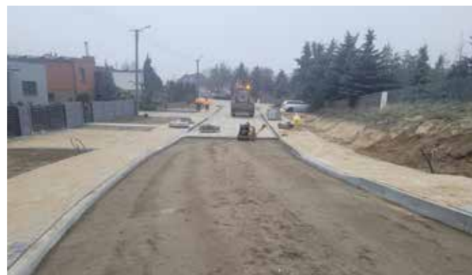
Ulica Akacja w trakcie robót budowlanych
