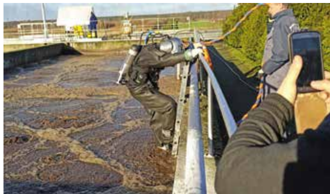
Wymiana dyfuzorów przez wyspecjalizowaną firmę posiadającą wieloletnie doświadczenie i odpowiedni sprzęt
