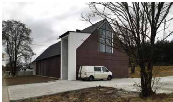
Sala wiejska w Marianowie w trakcie prac
