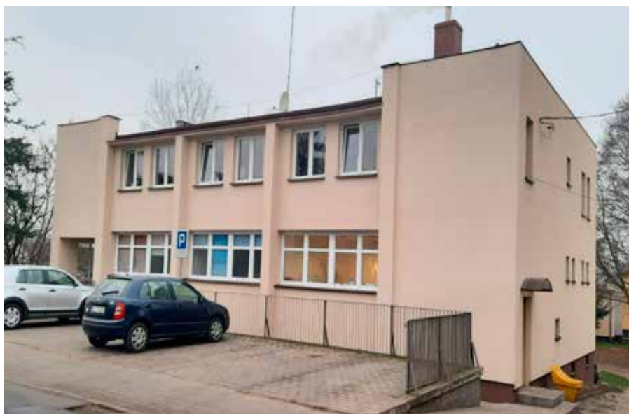
Nowa elewacja, docieplenie ścian budynku przy ul. Powstańców Wlkp. 23 w Rosku – Ośrodek Zdrowia
