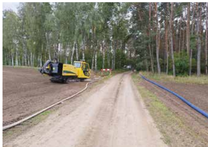
Gulcz Wybudowanie - sieć wodociągowa w trakcie robót
