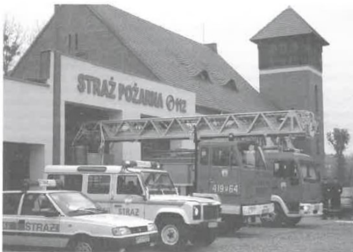
Centrum Ratowniczo-Gaśnicze przy ul. Lipowej w Wieleniu
