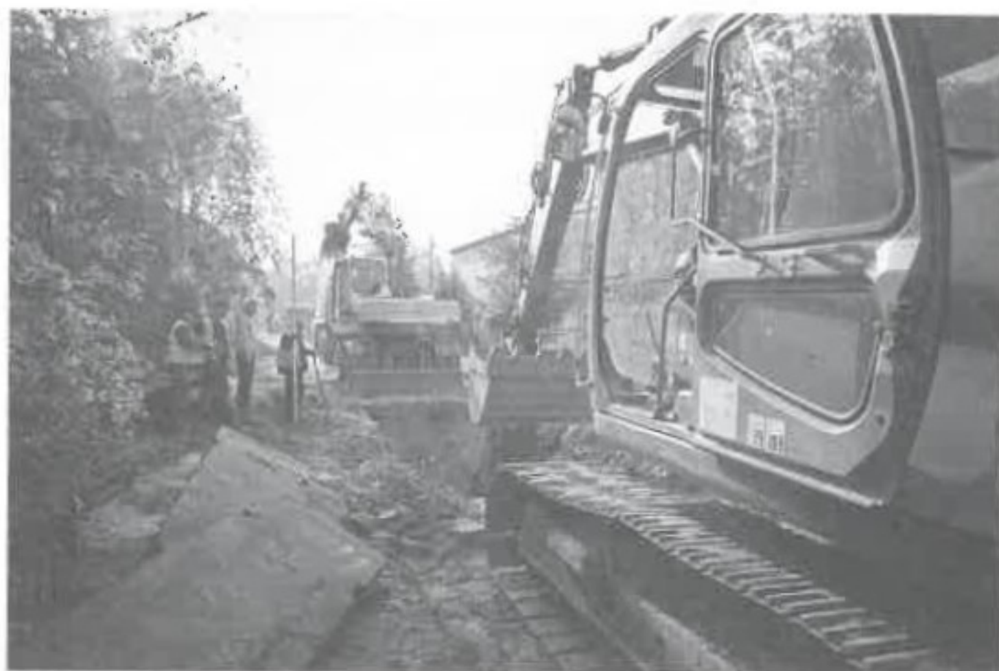
Prace kanalizacyjne na terenie miasta (2011 r.)
