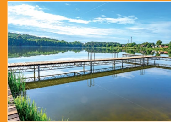
Plaża w Dzierżążnie Wielkim Strand in Groß Drensen
