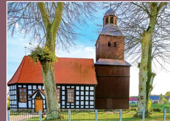
Kościół szachulcowy w Dzierżąźnie Wielkim Fachwerkkirche in Groß Drensen
