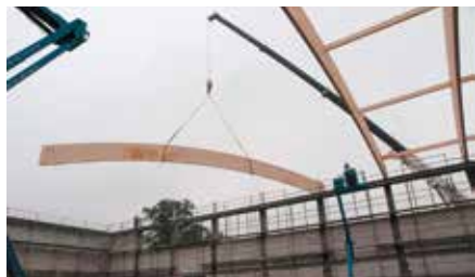
Budowa hali widowiskowo - sportowej w Wieleniu.
