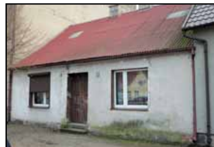
Budynek komunalny przy ul. Nowe Miasto 17 w Wieleniu przed remontem
