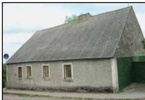
Budynek komunalny przy ul. Podgórznej 5 w Rosku przed remontem
