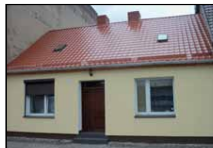
Budynek komunalny przy ul. Nowe Miasto 17 w Wieleniu po remoncie
