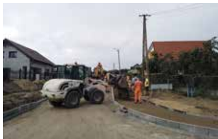
Przebudowa ulic w Wieleniu w trakcie prac
