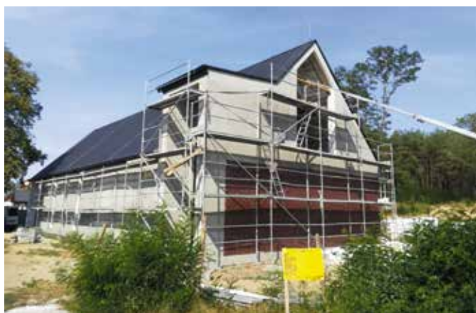
Sala wiejska Marianowo - Herburto w trakcie prac
