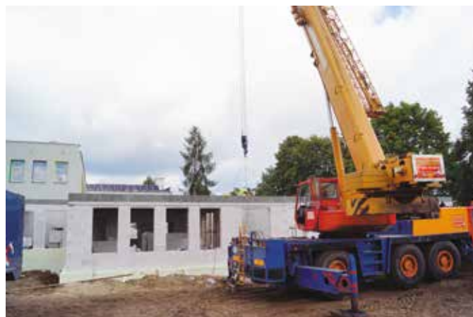
Prace przy układaniu stropu na obiekcie żłobka w Wieleniu
