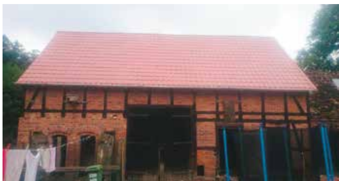
Tak wygląda dach po zakończonym remocie w Kuźniczce
