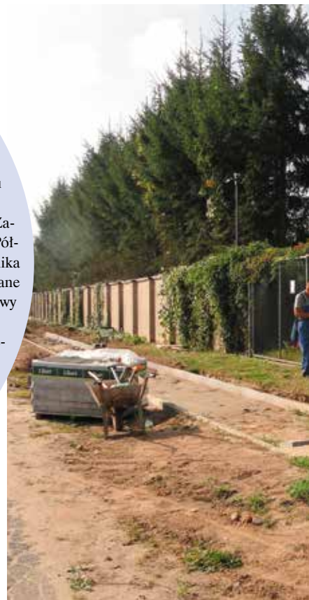
Prace budowlane przy chodniku w Rosku - fot. Hanna Forbrich
