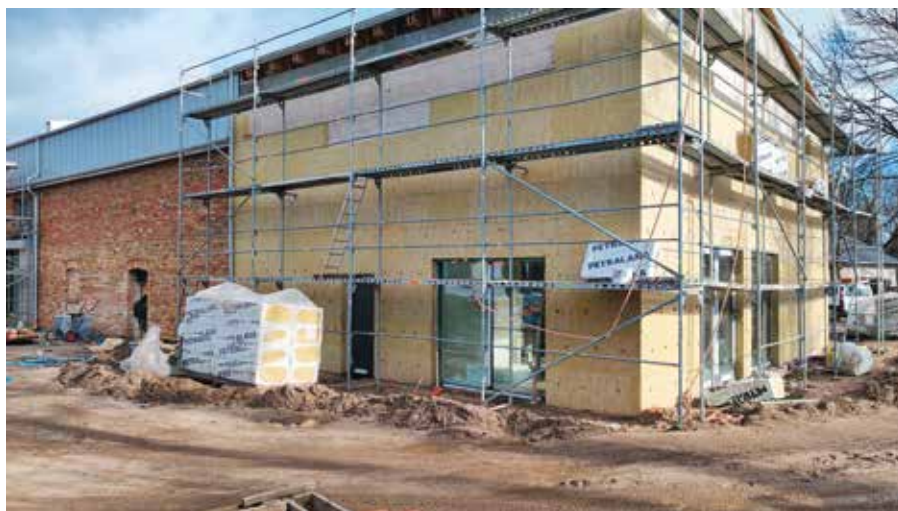
Mediateka w trakcie budowy widok od strony dziedzińca szkoły, fot. Rafał Figlarz
