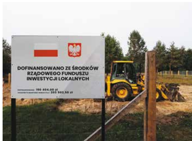
Zapewnienie dostępu do wody dla odbiorców z terenu Gminy Wieleń - budowa sieci wodociągowych w m. Nowe Dwory, Rosko, os. Międzyzlesie w Wieleniu, fot. Mikołaj Jagła
