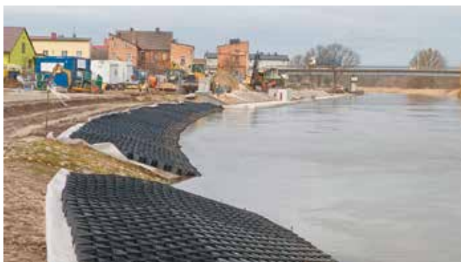
Bulwary nadnoteckie w Wieleniu- roboty budowlane, fot. Marcin Waśko
