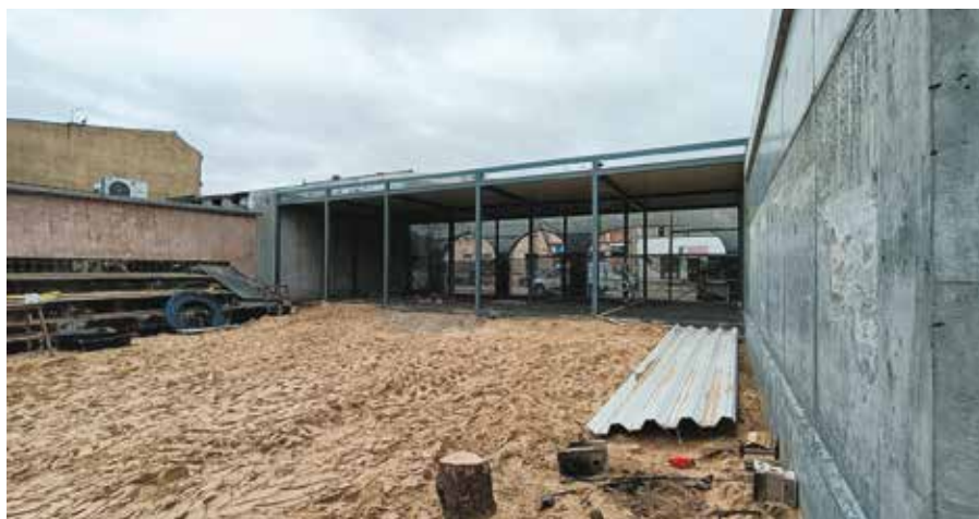
Przystanek Edukacja w trakcie prac, fot. Marcin Waśko
