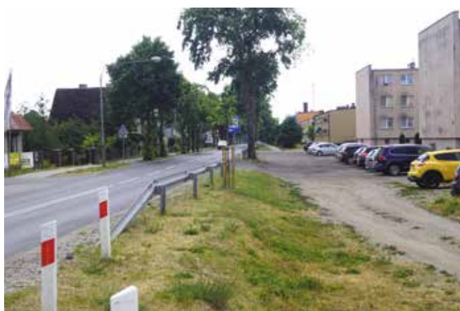
Wieleń, ul. Jana Pawła II ( przed budową chodnika ), fot. 20.06.2023 r., K. Ficner
