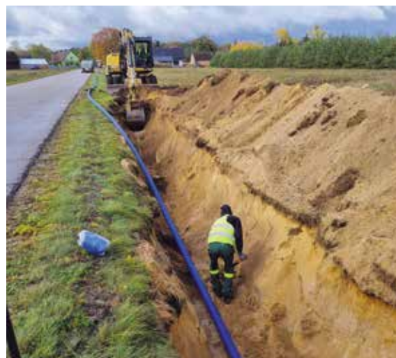
Sieć wodociągowa w Mężyku w trakcie budowy
