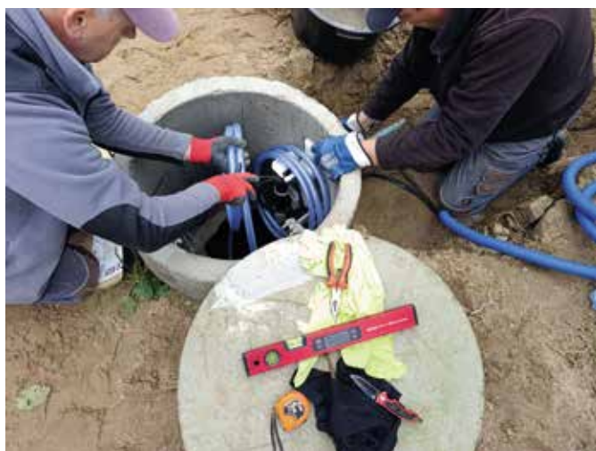
Modernizacja zbiornika bezodpływowego na biologiczną oczyszczalnię ścieków
