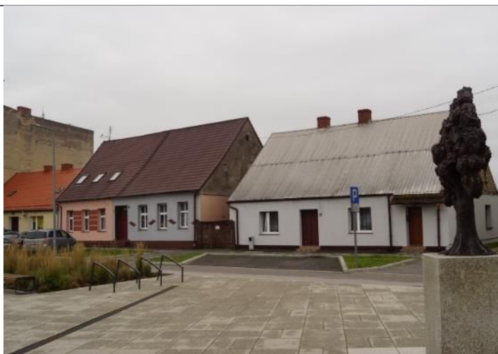
Nowe elewacje prywatnych budynków na Nowym Mieście
