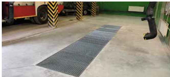
Posadzka w obiekcie OSP Wieleń
