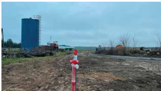
Zakończono prace przy odcinku sieci wodociągowej w Rosku
