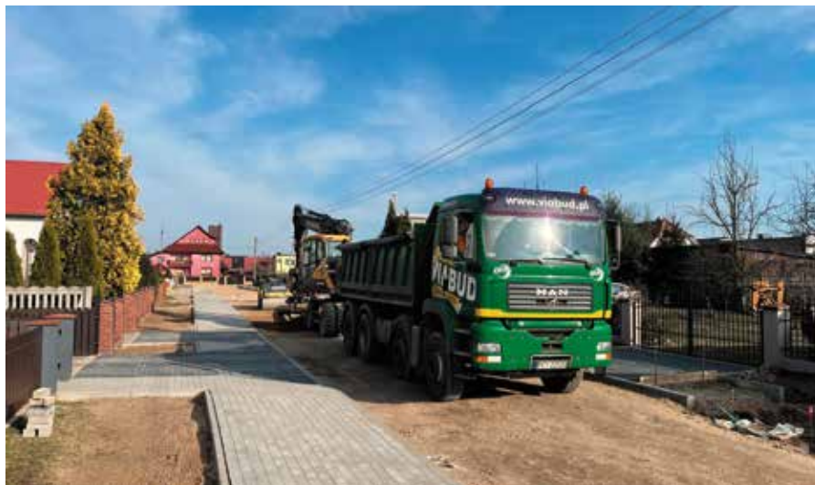
Prace budowlane drogowe na ulicach w Rosku
