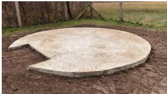
Fundament pod zbiornik retencyjny wody w Gulczu
