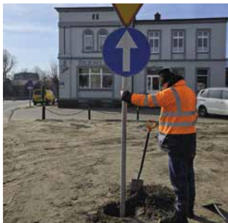
Naprawa uszkodzonych znaków drogowych na terenie Wieleń w ramach prac gospodarczych
