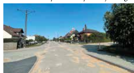
Ulica Tęczowa w Rosku w trakcie przebudowy
