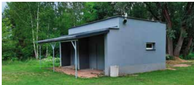
Budynek WTW przy ul. Sportowej w Wieleń
