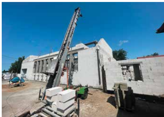
Sala wiejska w Gulczu w trakcie prac
