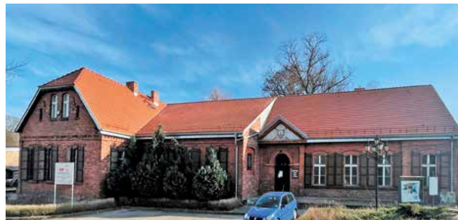
OK Strzelnica po remoncie dachu
