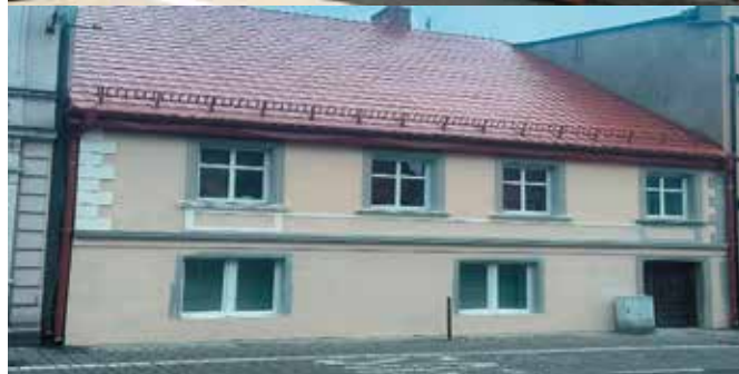
Budynek Kościuszki 9 - przed i w trakcie wykonywania elewacji
