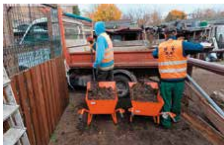
Prace porządkowe po oczyszczeniu rowu odpływowego na terenie gminnym
