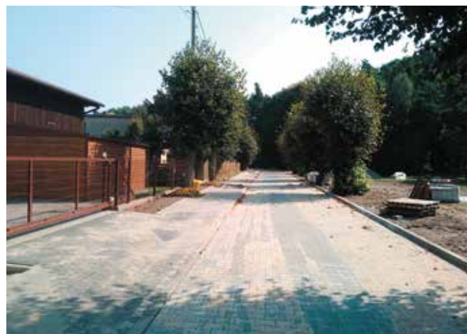
Przebudowa dróg w obrębie osiedla Północ w Wieleniu - w trakcie prac
