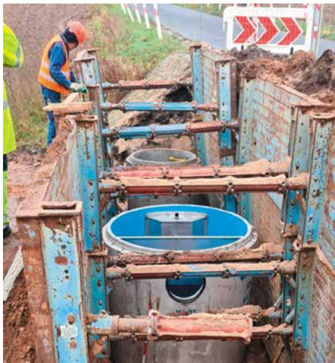
Sieć kanalizacji deszczowej w trakcie prac, fot. Hydropex Złotów
