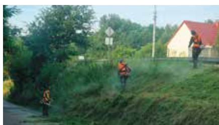
Koszenie i porządkowanie poboczy dróg gminnych
