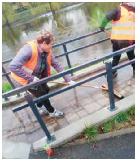
Porządkowanie terenu Bulwarów Nadnoteckich
