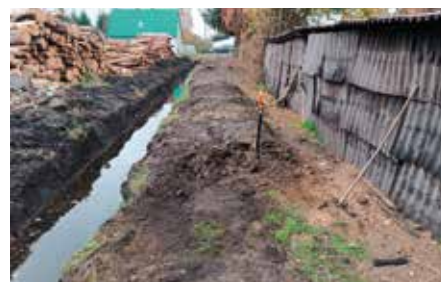
Oczyszczanie rowu odpływowego
