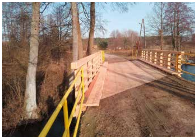
Most w Kuźniczce po pracach remontowych
