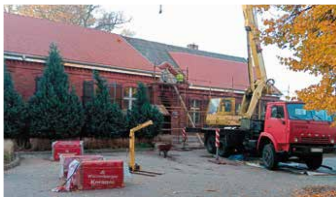
Ośrodek Kultury „Strzelnica” w trakcie prac remontowych dachu
