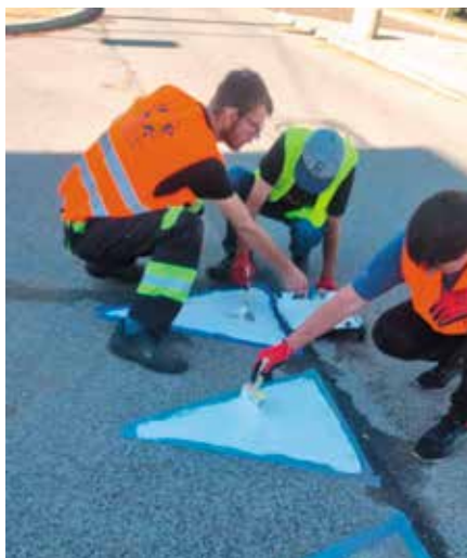
Malowanie poziomych znaków drogowych na terenie miasta Wieleń
