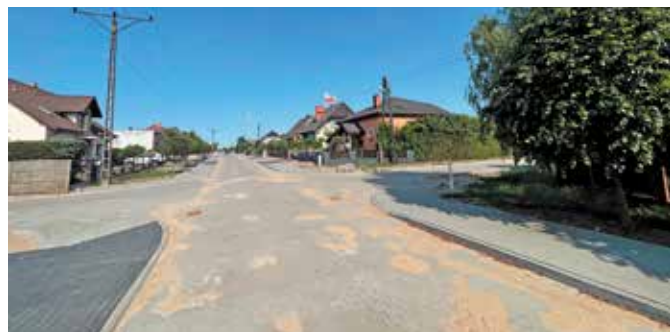
Ulica Tęczowa w Rosku po pracach związanych z ułożeniem nawierzchni
