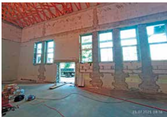
Sala wiejska w Gulczu w trakcie prac
