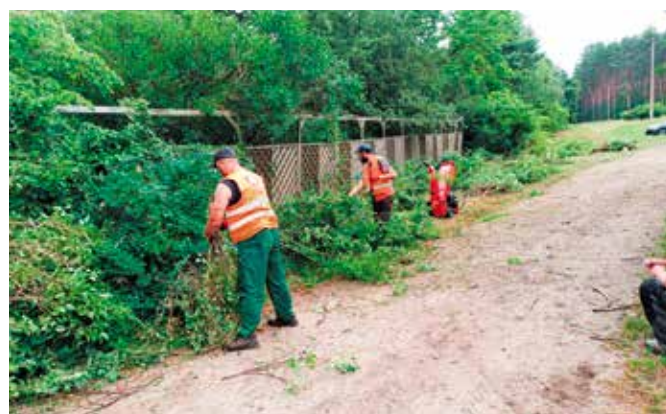
Oczyszczanie pobocza drogi gminnej na terenie Mniszek
