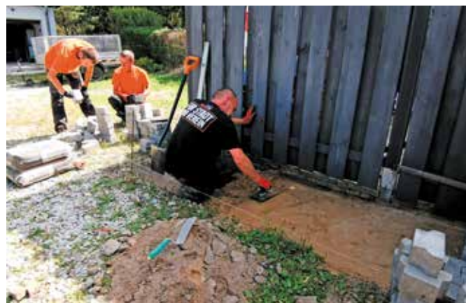
W ramach przyuczenia, układanie kostki brukowej koło siedziby CIS
