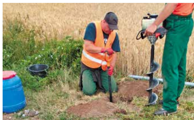
Montowanie znaku informacyjnego przy drodze przy pomocy wiertnicy spalinowej
