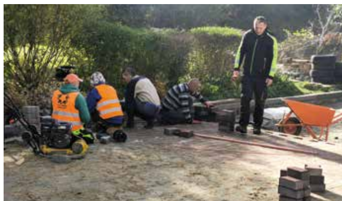
Utworzenie części terenu przed siedzibą CIS materiałem nieodpłatnie przekazanym przez lokalnego producenta kostki brukowej. Dla uczestników warsztatów CIS to nauka kładzenia takiej nawierzchni
