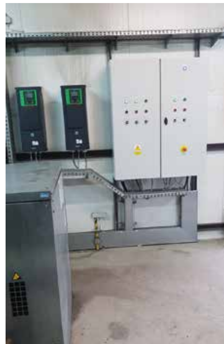
Wymieniono szafę sterowniczą dmuchaw. Koszt 15,5 tys. zł
