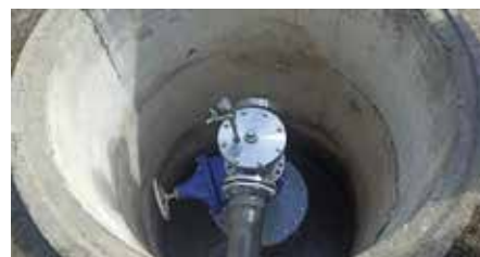
Zmodernizowano komorę studni i wy- mieniono skorodowaną głowicę studni na ujęciu wody w Wieleń przy ul. Janka z Czarnkowa (2023).
