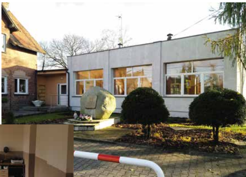
Elewacja budynku Szkoły Podstawowej w Miałach
