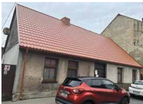
Budynek przy ul. Kasprzaka 10 w Wieleń w trakcie i po remoncie pokrycia dachowego.
