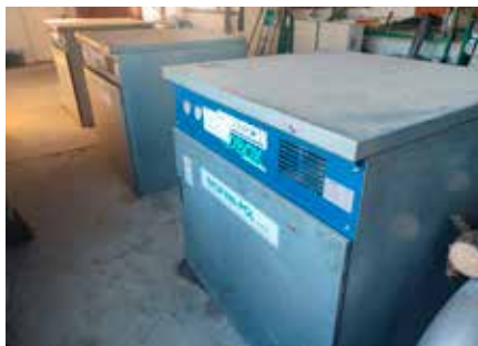
Na oczyszczalni ścieków przy ul. Jaryńskiej wymieniono główną dmuchawę, a pozostałe wyremontowano (2020-2021). Koszt ok. 55 tys. zł
