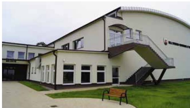
Hala sportowo- widowiskowa w Wieleniu
