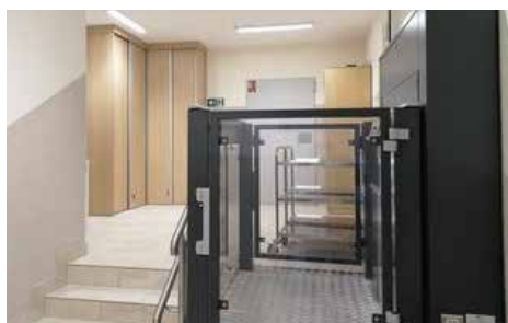
Winda w Gminnym Żłobku w Wieleniu
