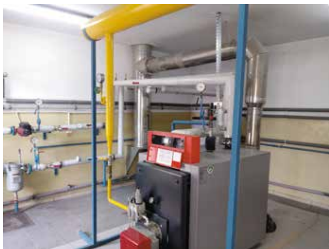
Modernizacja kotłowni w Zespole Szkół w Wieleniu
