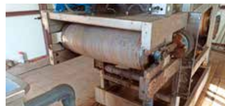
Wykonano remont prasy do odwadniania osadów (2022). Koszt ok. 17 tys. zł
