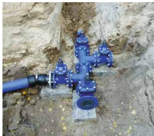
Sieć wodociągowa Gulcz. Wybudowanie w trakcie prac
