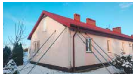
Zabezpieczono podporami wyłączony z eksploatacji budynek przy ul. Jaryńskiej (2019). Koszt zabezpieczenia ok. 1,7 tys. zł/miesiąc
