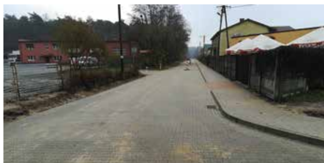
Ulica Sosnowa w Wieleniu po przebudowie
