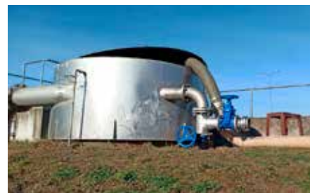
Wykonano remont przepompowni głównej oraz modernizację piaskownika (2022). Koszt 177.120,00 zł
