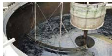
Przeprowadzono oczyszczanie zbiorników wtórnych na oczyszczalni przy ul. Jaryńskiej.
