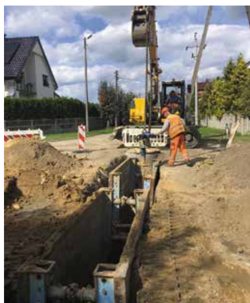
Kanalizacja deszczowa w Rosku w trakcie prac
