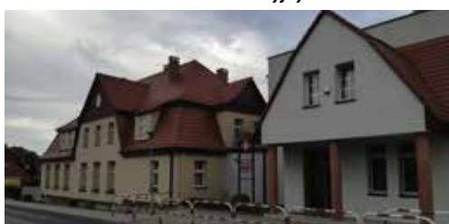
SP Rosko po termomodernizacji
