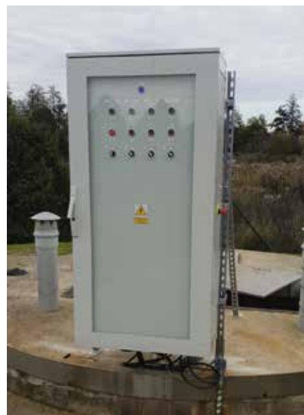
Wymieniono system sterowania głównej przepompowni na oczyszczalni ścieków. Koszt ok. 174 tys. zł
