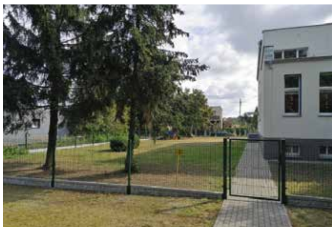
Wygrodzenie terenu Gminnego Przedszkola w Wieleniu
