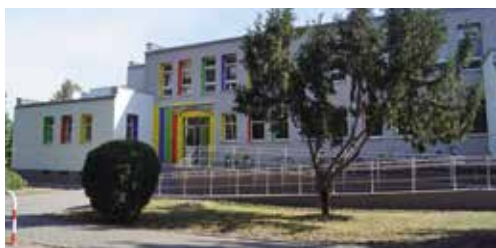
Przedszkole w Wieleniu po pracach termomodernizacyjnych
