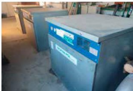
Na oczyszczalni ścieków przy ul. Jaryńskiej wymieniono główną dmuchawę, a pozostałe wyremontowano (2020-2021). Koszt ok. 55 tys. zł
