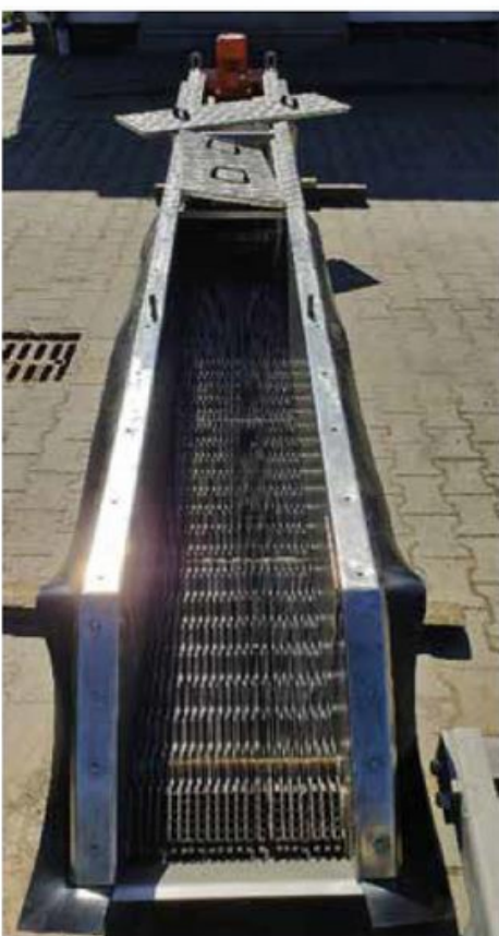
Przeprowadzono remont kraty schodkowej (2020-2021). Koszt ok. 55 tys. zł
