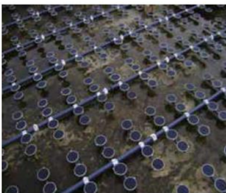
Przeprowadzono wymianę dyfuzorów na oczyszczalni ścieków przy ul. Jaryńskiej (2022). Koszt ok. 151 tys. zł
