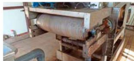
Wykonano remont prasy do odwadniania osadów (2022). Koszt ok. 17 tys. zł
