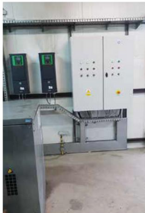
Wymieniono szafę sterowniczą dmuchaw. Koszt 15,5 tys. zł
