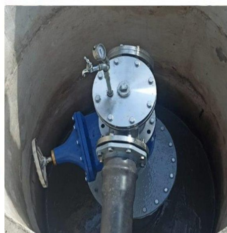
Zmodernizowano komorę studni i wymieniono skorodowaną głowicę studni na ujęciu wody w Wieleniu przy ul. Janka z Czarnkowa (2023 r.) Koszt ok. 36 tys. zł.
