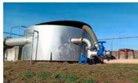
Wykonano remont przepompowni głównej oraz modernizację piaskownika (2022). Koszt 177.120,00 zł
