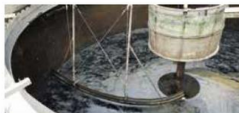
Przeprowadzono czyszczenie zbiorników wtórnych na oczyszczalni przy ul. Jaryńskiej.
