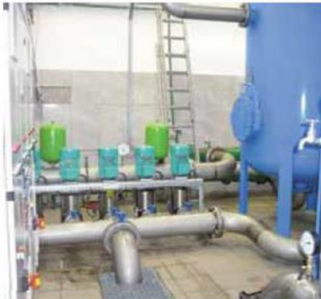
Modernizacja stacji uzdatniania wody przy ul. Janka z Czarnkowa w Wielniu (inwestycja gminna). Przebudowa hydroforu i systemu sterowania wraz z uzdatnianiem wody (2018). Koszt ok. 1,6 mln zł
