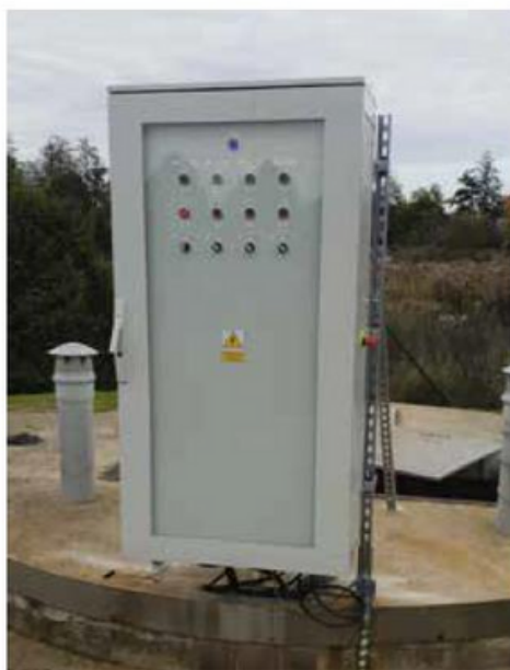
Wymieniono system sterowania głównej przepompowni na oczyszczalni ścieków. Koszt ok. 174 tys. zł
