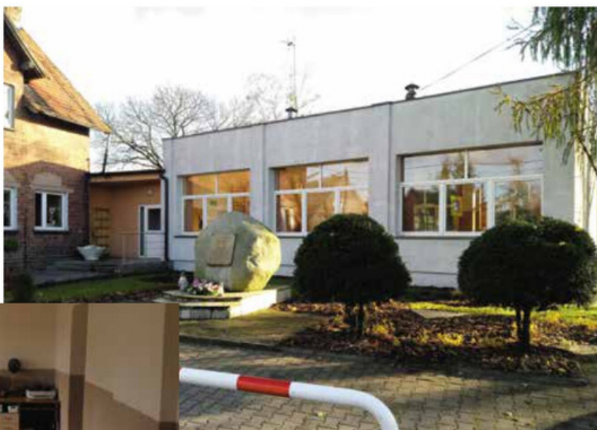
Elewacja budynku Szkoły Podstawowej w Miałach
