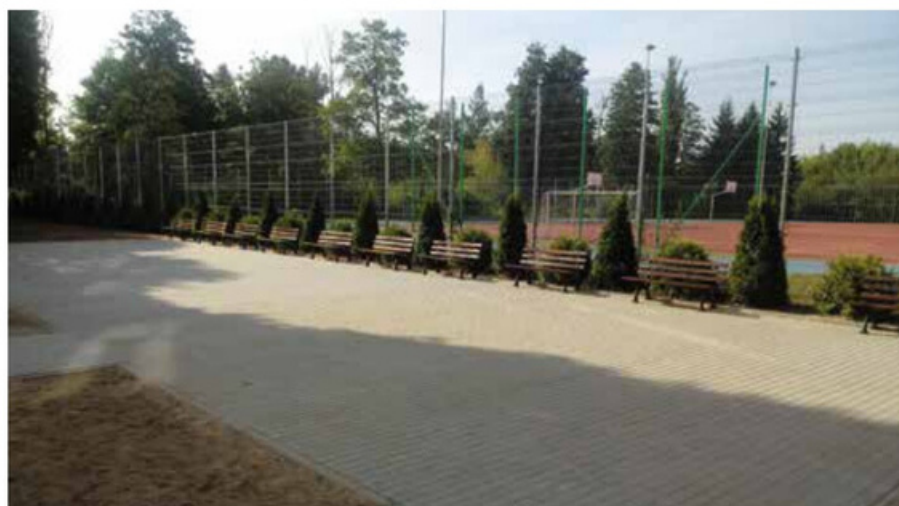
Utwardzenie placu apelowego w Szkole Podstawowej Nr 1 w Wieleniu
