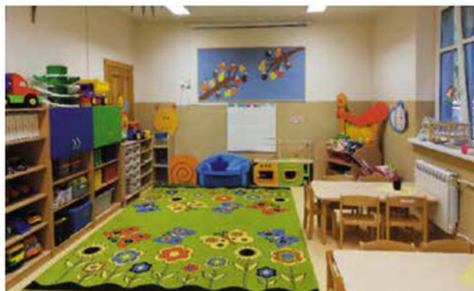
Kompleksowy remont sali oddziału przedszkolnego w Rosku
