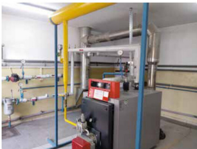
Modernizacja kotłowni w Zespole Szkół w Wieleniu
