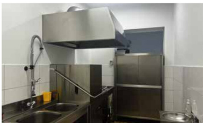
Zmywalnia po remoncie w Szkole Podstawowej w Rosku
