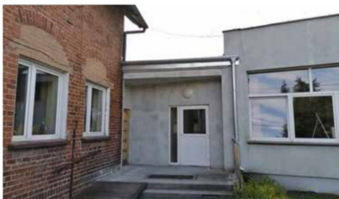
Remont dachu papowego oraz ocieplenie ściany szczytowej w budynku B – SP Miały
