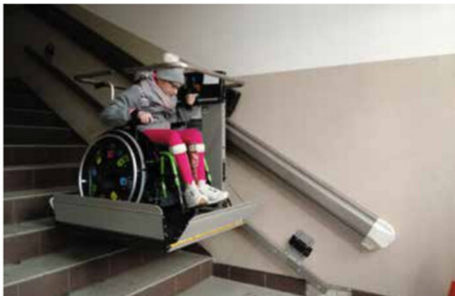
Platforma dla osób niepełnosprawnych w Szkole Podstawowej nr 1 w Wielki
