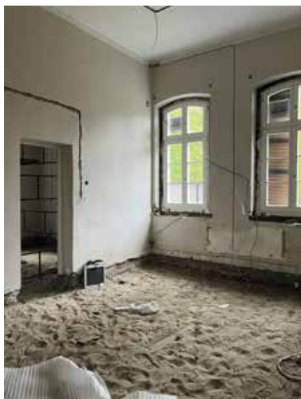
OK Strzelnica - prace na parterze budynku
