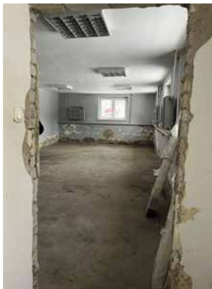
WDK Rosko - pomieszczenie Klubu w trakcie prac
