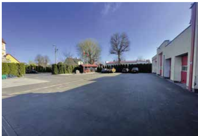
Plac przed OSP Wieleń po zakończeniu prac
