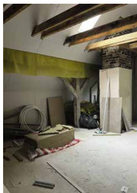
OK Strzelnica - poddasze w trakcie prac remontowych
