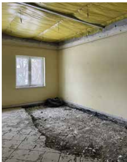
Sala główna WDK Rosko w trakcie prac modernizacyjnych
