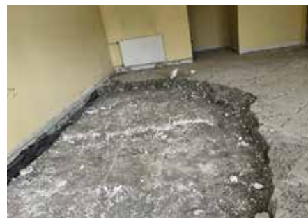
Prace modernizacyjne WDK Rosko
