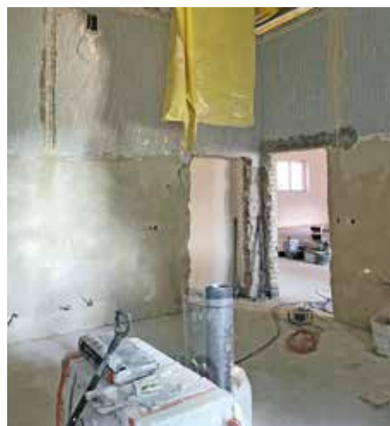
Roboty budowlane w obiekcie WDK Rosko
