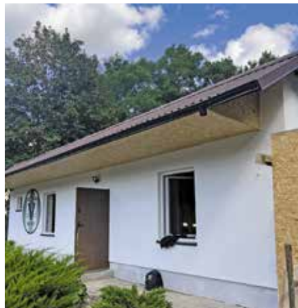
Szatnia w Miałach w trakcie prac remontowych
