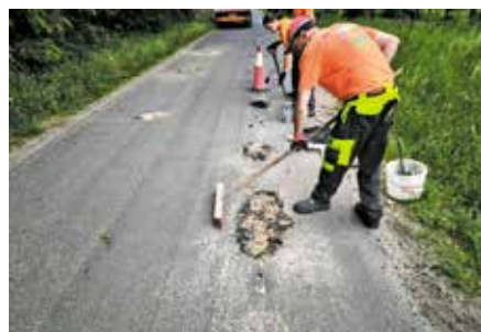
Naprawa nawierzchni drogi gminnej w kierunku miejscowości Biata
