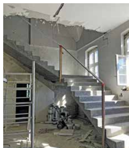
OK Strzelnica w trakcie prac modernizacyjnych
