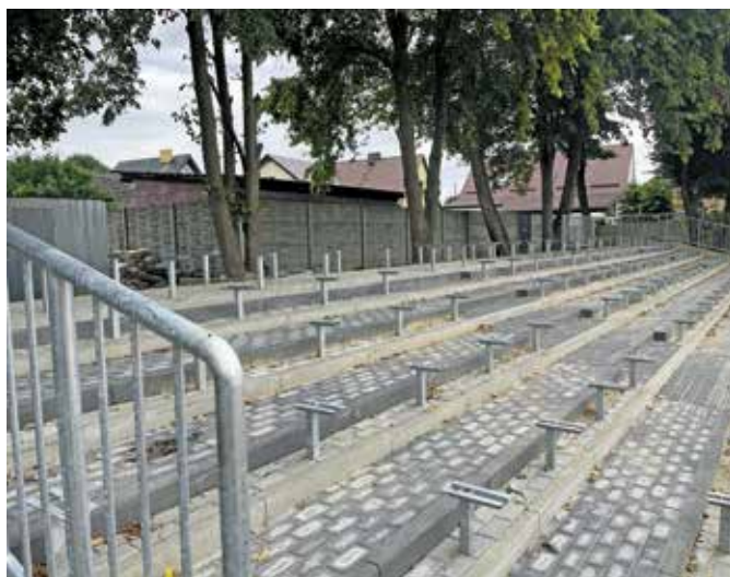
Trybuny przy WDK Rosko w trakcie prac
