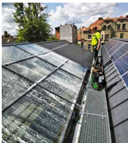
Czyszczenie zadaszenia Targowiska Miejskiego w Wieleniu na zlecenie Gminy Wielen
