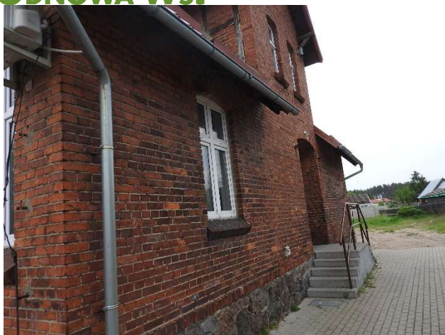
Zdjęcie 7 Teren przy świetlicy wiejskiej w miejscowości Biała
