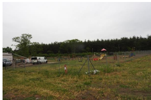
Zdjęcie 14 Teren budowy nowej Sali Wiejskiej
