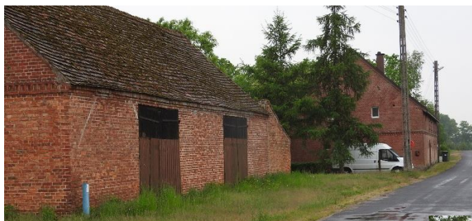
Zdjęcie 5 Zabytkowy budynek
