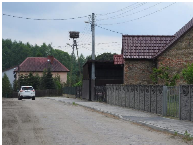
Zdjęcie 2 Droga z zabudowaniami na terenie miejscowości
